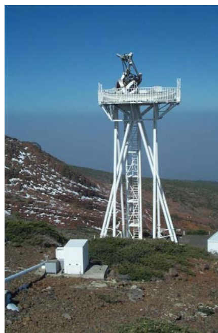
図 I-2-2. Dutch Open Telescope。口径 45cm で大きくは無いが、初めて開放型望遠鏡で回折限界を実現できることを示し、地上太陽望遠鏡の大型化への道を開いた。
